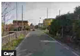
Carpi Lavori sul tratto urbano di Carpi della linea ferroviaria Modena-Mantova
